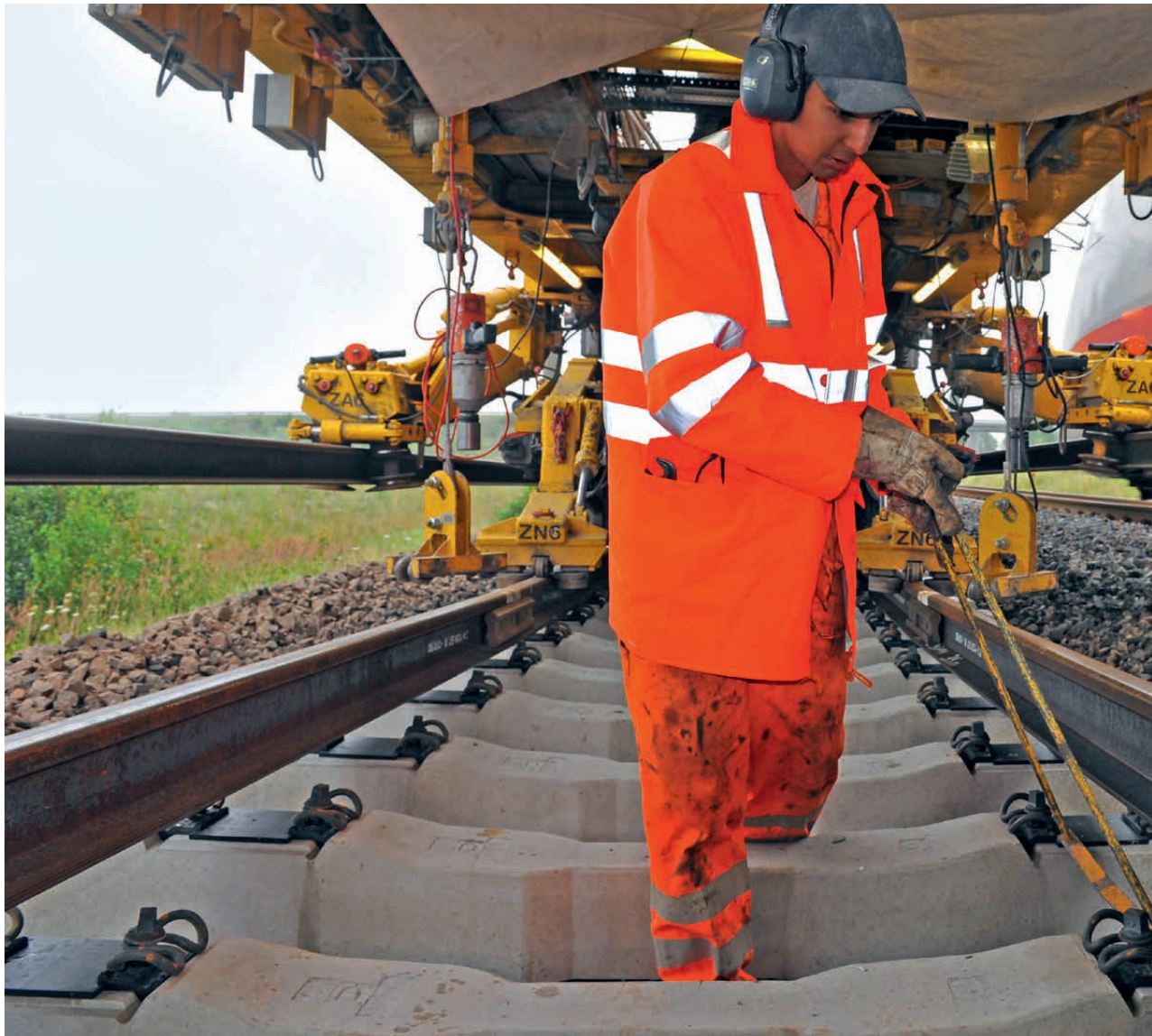
Ein Mitarbeiter von DB Bahnbau bereitet eine Schwelle zur Aufnahme der Schiene vor
