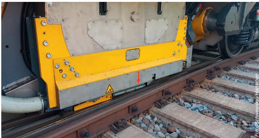
Abbildung 14: Drehhobelaggregat während der Herzstückbearbeitung
