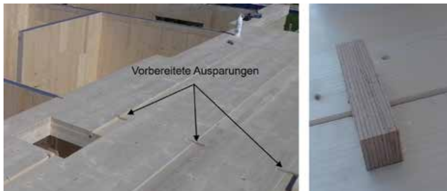
Bild 11: Abgebundene und verlegte Brettsperrholzelemente mit Aussparungen (links) und Einbau eines Kontaktverbinders Merkle XL-Connect® Q-100 (rechts)
