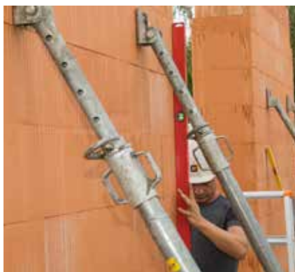
Bild 3: Anbringen der Montagestützen zur Lagesicherung. Quelle: Schlagmann Poroton, Kellerfotografie
