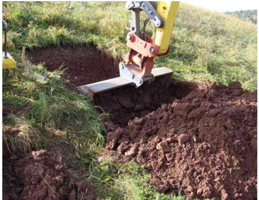
Bild 2: Beispiel für einen Erkundungsschurf in einer Oberflächenabdichtung
