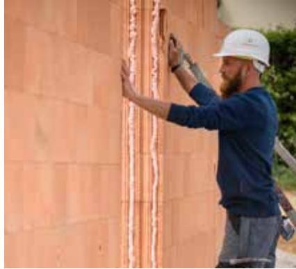
Bild 4: Verschließen der Elementfugen mit Redbloc-Montagekleber. Quelle: Schlagmann Poroton
