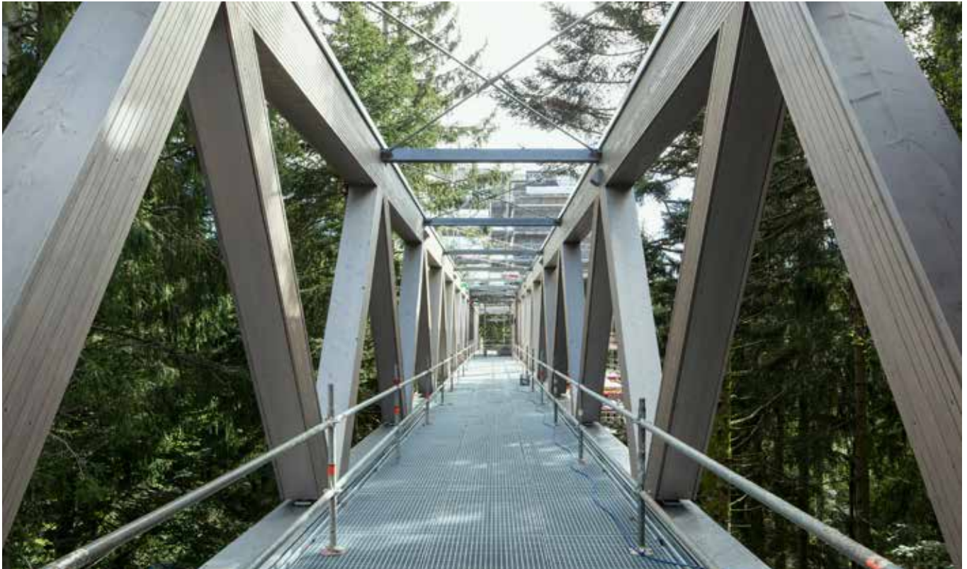
Bild 13: Die Brücke zum Aussichtsturm, der Skywalk, ist als Fachwerk-Konstruktion ausgeführt. Blech-Abdeckungen und Verschalungen schützen ihn vor Regen und anderen Witterungseinflüssen. (Bildquelle: Dirk Altenkirch)
