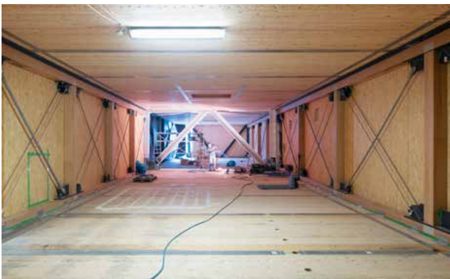
Bild 12: Gurte und Druckpfosten aus BauBuche sowie Stahl-Zugstangen bilden die N-Fachwerke des Riegels B. Gegenläufige weitere Zugstäbe sorgen für deren zusätzliche Aussteifung. (Foto: ZÜBLIN Timber)
