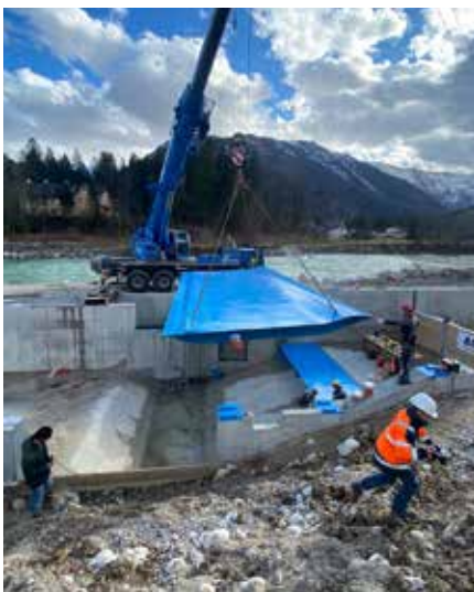
Die Stahlwasserbauklappe wird mit einem Kran eingehoben. (© concon – construction consulting)
