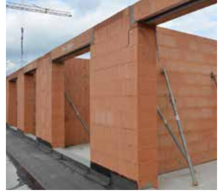
Bild 5: Bereits werksseitig können Rollladenkästen eingebaut werden. Quelle: Schlagmann Poroton
