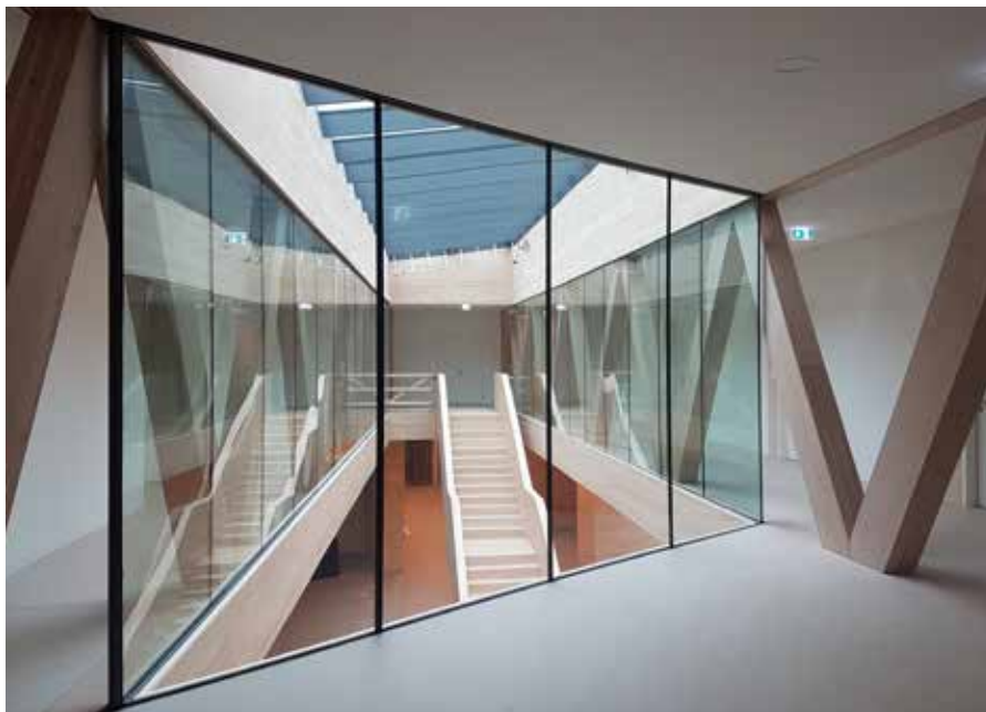
Bild 14: Das großzügige Foyer des neuen Nationalparkzentrums mit viel Holz auch im Innenausbau unterstreicht die Funktion des Gebäudes zusätzlich. Teile des hochkomplexen Tragwerks sind noch sichtbar, etwa das Fachwerk aus BauBuche in den Riegeln G und H über der Treppe. (Bildquelle: Dirk Altenkirch)
