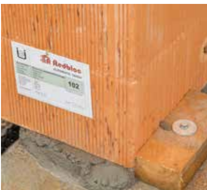
Bild 2: Wandelement wird vollflächig in das Mörtelbett gesetzt. Quelle: Schlagmann Poroton, Kellerfotografie
